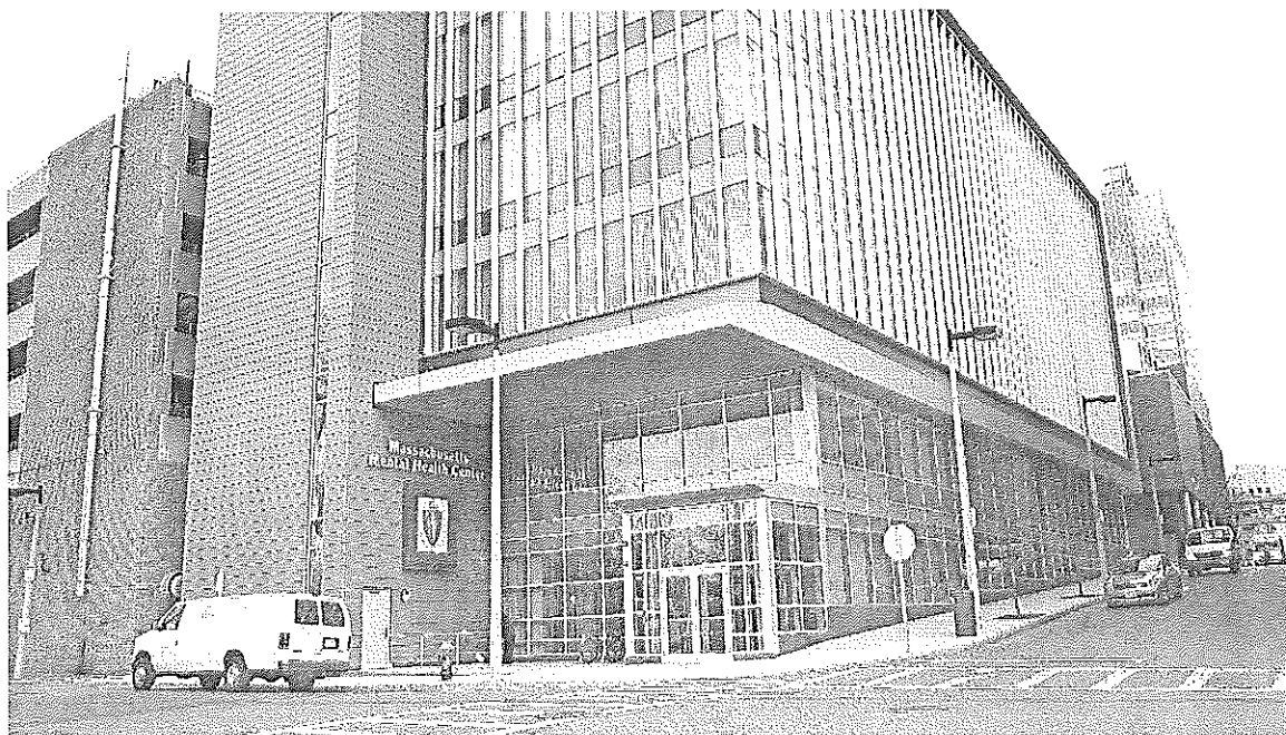
麻州精神衛生中心
