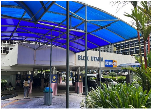
圖 19 Kuala Lumpur Hospital 建築外觀
