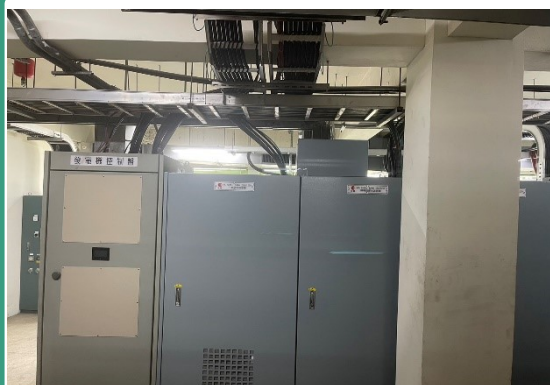
老舊變電站汰換(迴旋中心)
