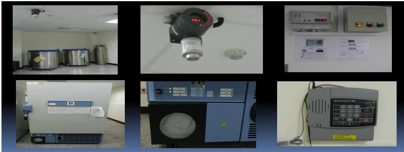
儲存設備氧氣監測、冰箱溫度監控、遠端撥接警報系統
