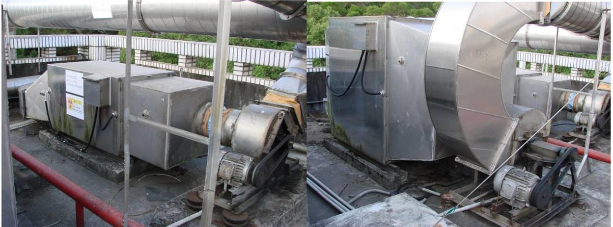
圖11 排放管路設置HEPA與活性炭濾層過濾系統
